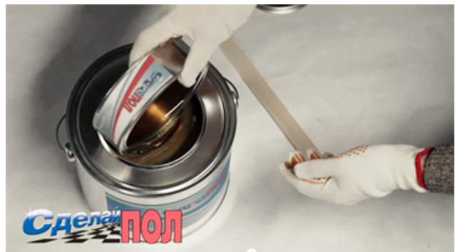
**Внимание! Максимальный срок годности состава после введения отвердителя составляет 8 часов при температуре +20°C.** По окончании окрасочных работ нужно исключить хождение по свежеокрашенной поверхности, а также попадание пыли, грязи, воды и пр. в течение 24 часов.
